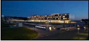
Das Gebäude der Chirurgie | Dermatologie bei Nacht. Stand Juli 2012
