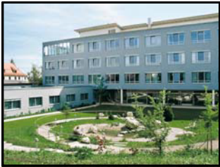
Außenansicht_Gesundheitszentrum _Ehingen Presse.jpg
